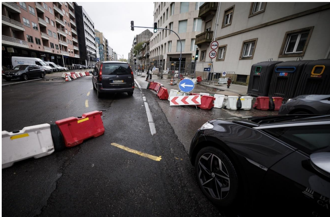
Foto 22 - Barreiras delimitadoras do espaço que se deslocaram, estrangulando uma mudança de direção que passou de duas a uma faixa de rodagem (sentido ascendente da Avenida da Boavista) (28 março 2024).
