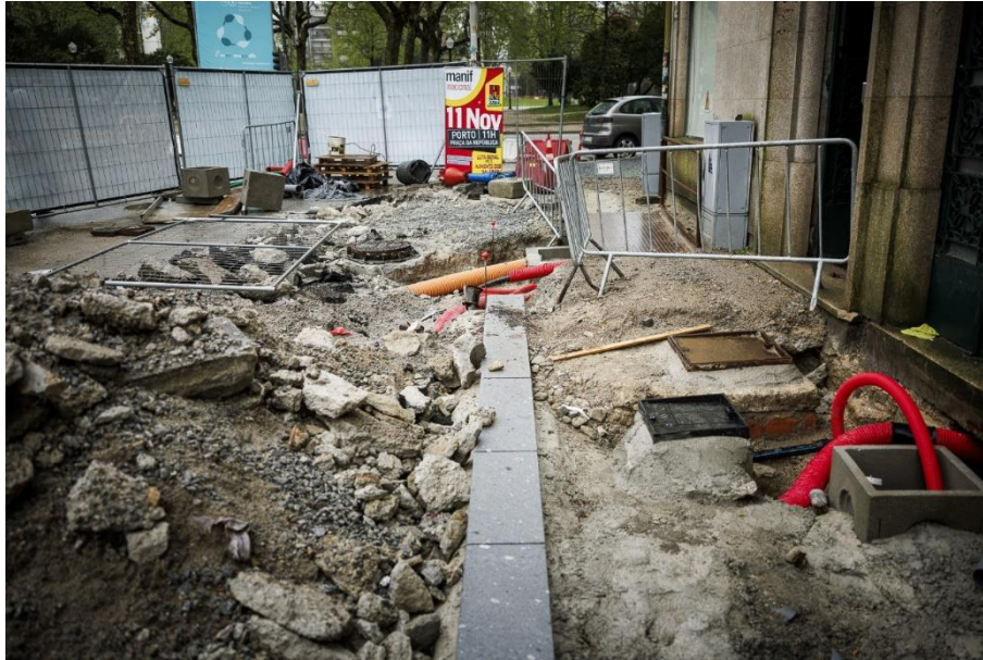
Foto 11 - Acesso provisório a um edifício comercial e de serviços na Avenida da Boavista (28 março 2024).
