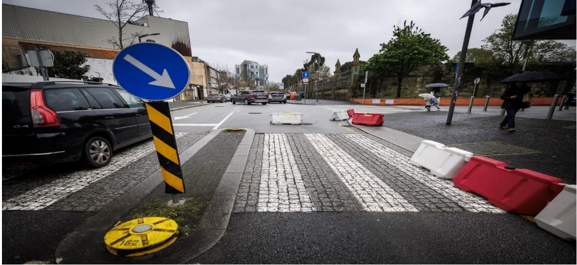
Foto 12 - Incoerência entre a sinalização vertical e os sentidos de circulação (Rua de Agramonte) (28 março 2024).
