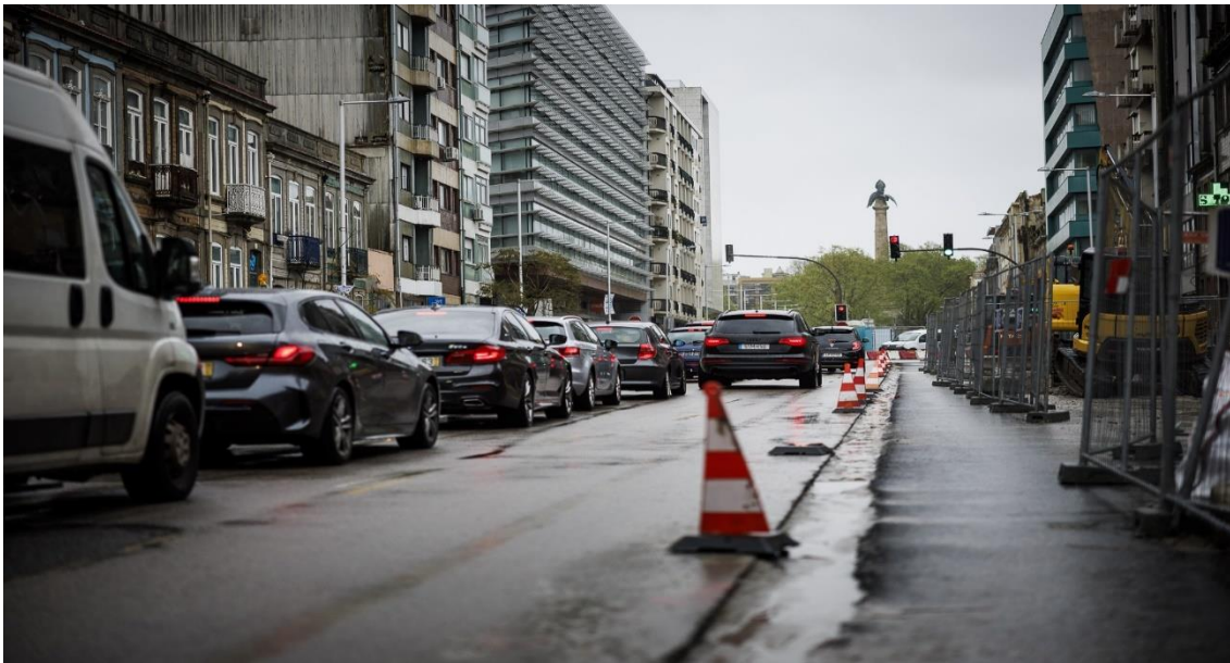
Foto 3- Passeio provisório na Avenida da Boavista (28 março 2024).
