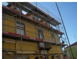
Figura 11 – Reforço da envolvente opaca.
