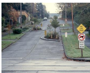
Figura 3 – Restrição de entrada de intersecções
