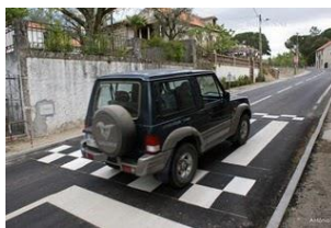
Figura 7 – Travessias pedestres sobre-elevadas.
